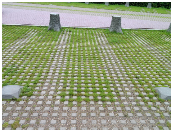
Parkovací stání – zatravněvací dlažba
